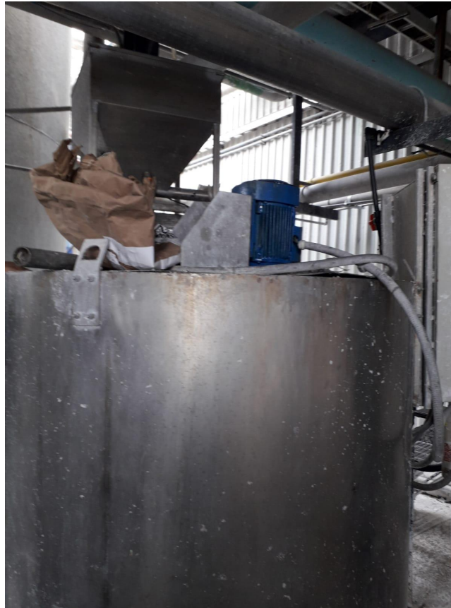
Imagen 2.1.- Instalación mecánica y eléctrica de actuadores
